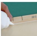
Ziehen Sie einen schmalen Streifen pH-neutralen Klebers entlang der Innenseiten der Leisten.
